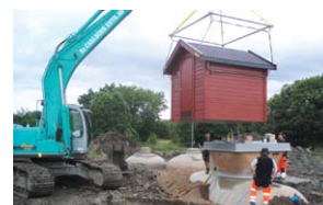
Et Green Clean-anlegg nærmer seg fullføring. Foto: Vestfold Plastindustri
