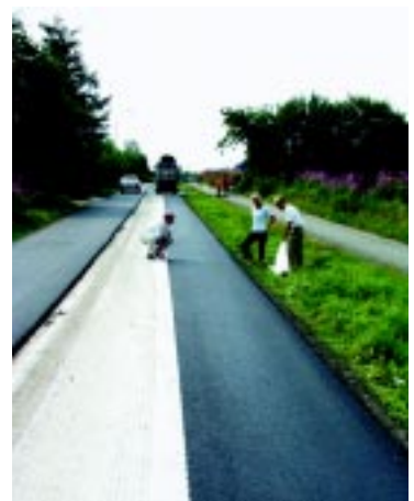
Små mengde karbonfiber i asfalt kan redusere trafikkslitasje og sprekkdannelser ved telehiv.
