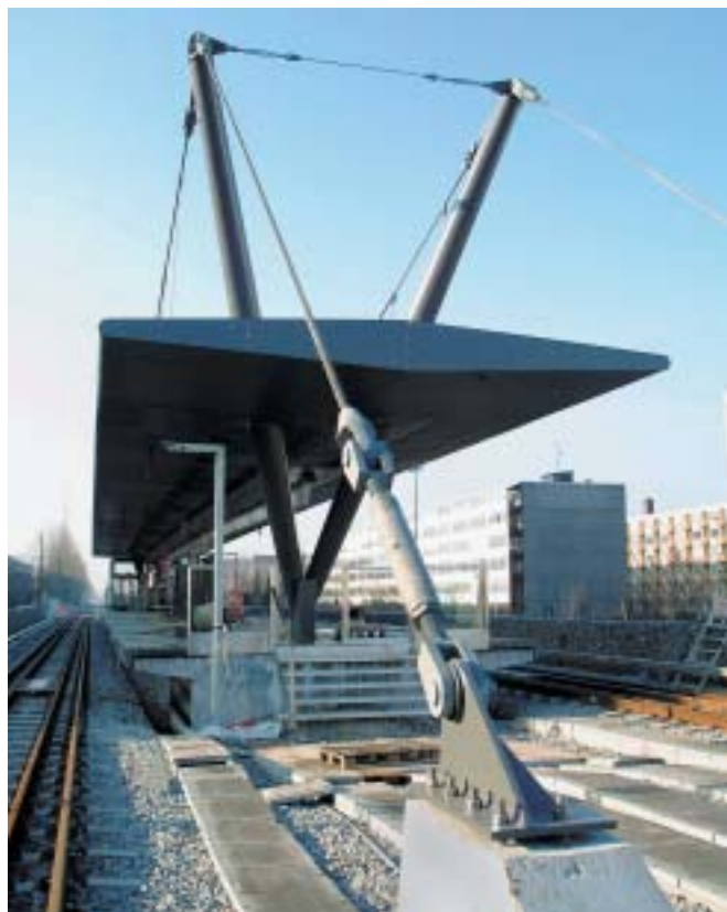
Perrontaget på Lindevang Station er 60 meter langt og 7,5 meter bredt. Det er båret af wirer fastgjort til fire pyloner i enderne.
