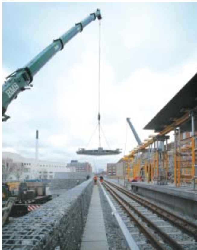
Perrontaget er leveret i syv sektioner, som derefter er limet sammen på stedet.
